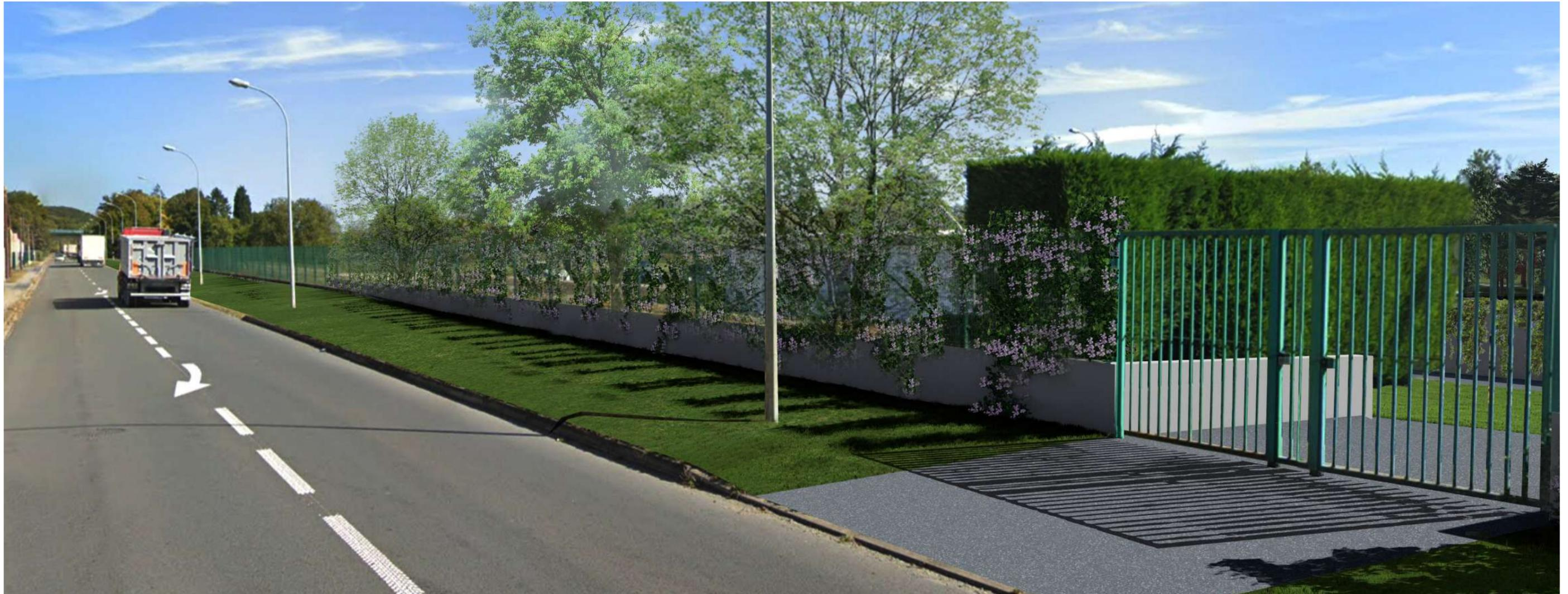
Le long de la route de Choisy, le mur de digue prends place à l'emplacement du muret déjà existant. Sur cette section le mur de digue fera entre 0.6 et 1 m de haut. La clôture existante, ou similaire, sera posée sur le muret de digue, pour une hauteur totale de 2m.
